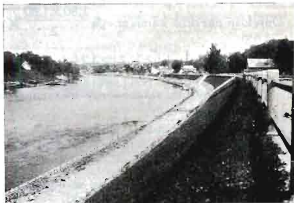
Rys. 5. Fragment z wykonanych robót regulacyjnych.
