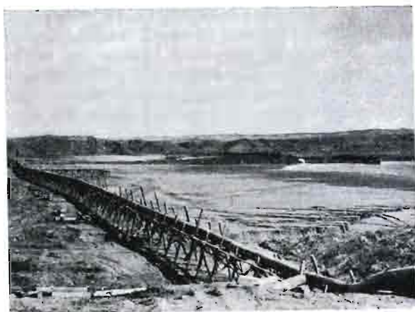
Rys. 5. Rurociąg do spławiania materiału ziemnego na zapórę.
