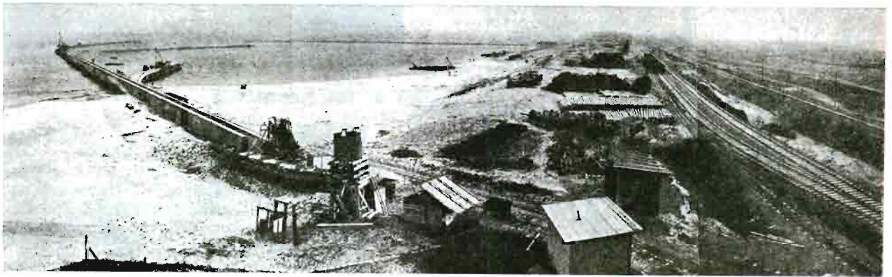
Rys. 1. Stan robót przy budowie portu rybackiego w Wielkiej Wsi w dn. 10. XI. 1936 r.
