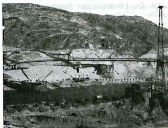
Rys. 17. Grodze lewo i prawostronne oraz most wiszący.
