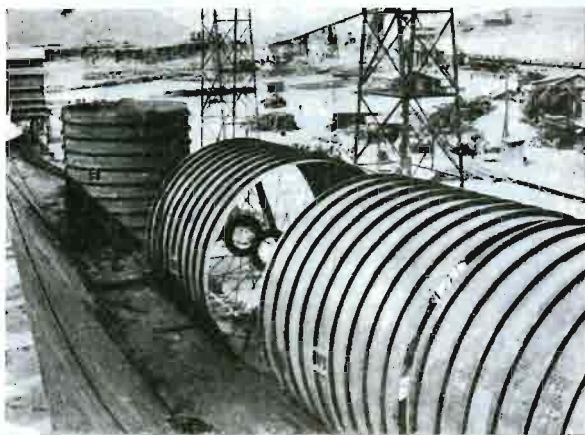
Rys. 9. Rury stalowe do sztolni obiegowej.
