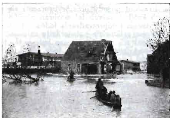
Rys. 2. Dom w Łęgnowie częściowo zniszczony przez powódź.
