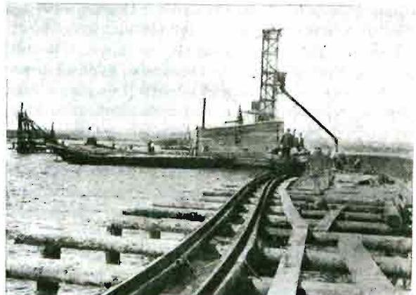
Rys. 6. Betonowanie płyty żelbetowej mola zachodniego.
