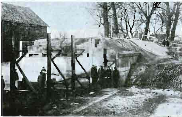
Rys. 2. Fragment z budowy upustu.
