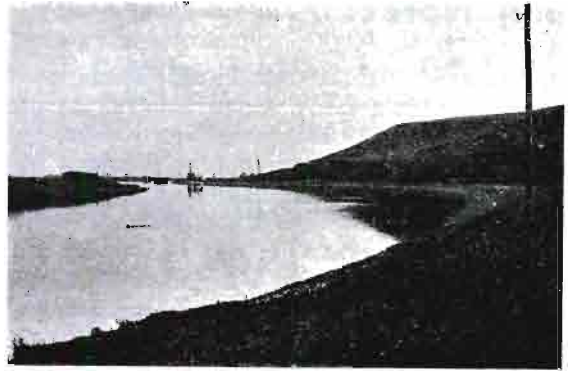
Rys. 6. Brzeg po ukończeniu budowy.
