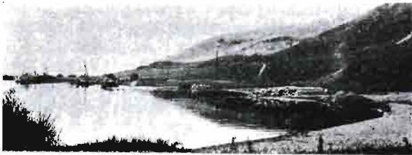
Rys. 5. Wyrwa po częściowym zasypaniu.
