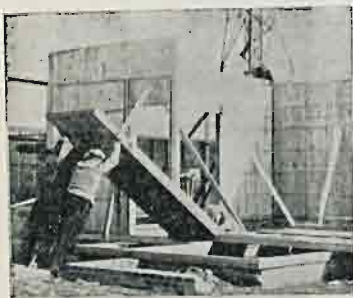
rys. 334 Dom w budowie; konstrukcja dr. inż. M. Wagnera
