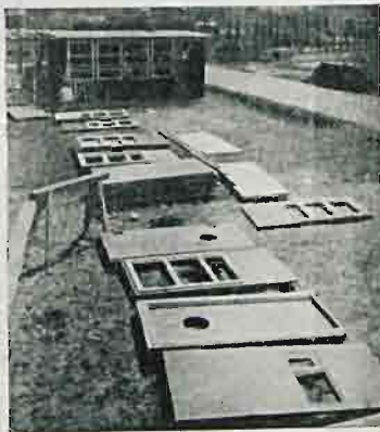
rys. 335 Budowę rozpoczęto o godz. 9 rano; konstrukcja prof. Otto Bartning.
