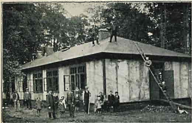
rys. 759 Budynek przedszkola w Tarnowskich Górach po zmontowaniu (12—16/9.1931 r.) (Styki elementów ściennych widoczne).
