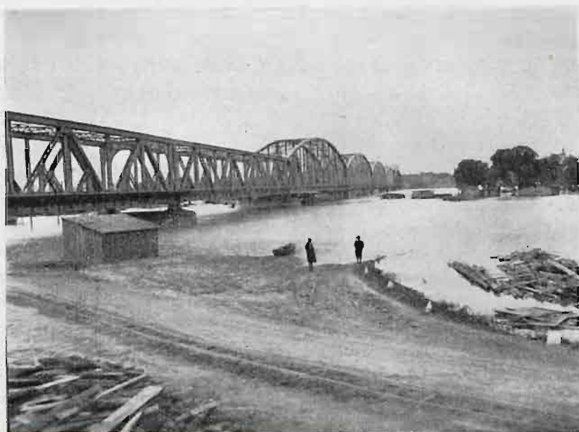
Rys. 11. Most Wiśle w Toruniu; rozpiętość 3 \times 80 + 5 \times 125 = 865 m.; budowę rozpoczęło w 1928 r.
