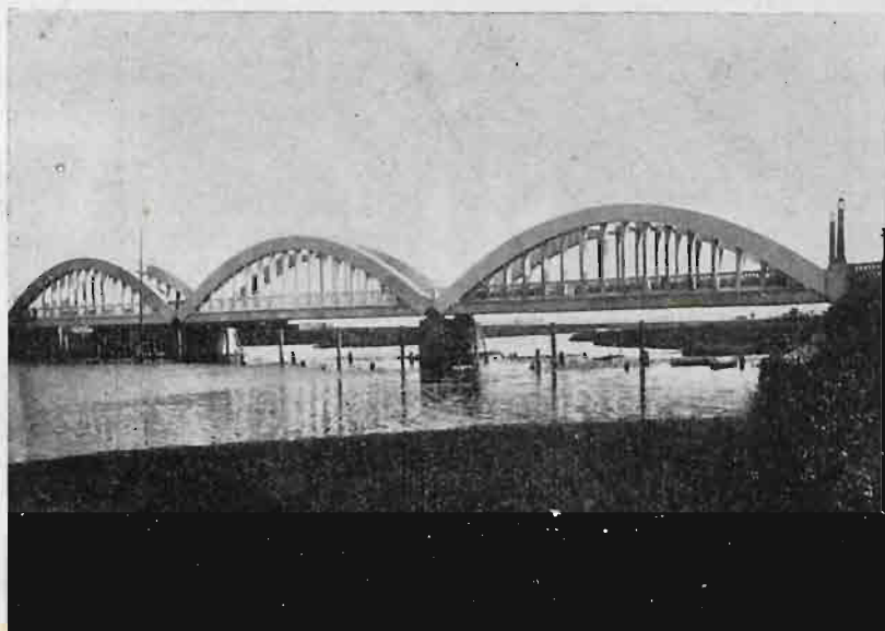
Rys. 2. Most na Bzurze w Łowiczu; rozpiętość 3 \times 31.12 = 93.36 m.; okres budowy 1927—1930 r.
