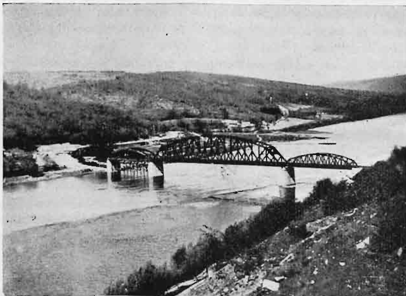
Rys. 7. Most na Dniestrze pod Uścieczkiem; rozpiętość 40 + 100 + 40 + 40 = 220 m; okres budowy 1928—1930 r.
