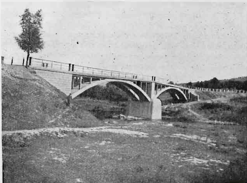
Rys. 6. Most na Wiśloku pod Żarnową; rozpiętość 35 + 35 = 70 m; okres budowy 1927—1930 r.
