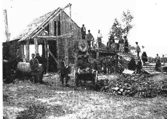
Rys. 4. Tłukarka w Berestowcu do produkcji tłucznia.
