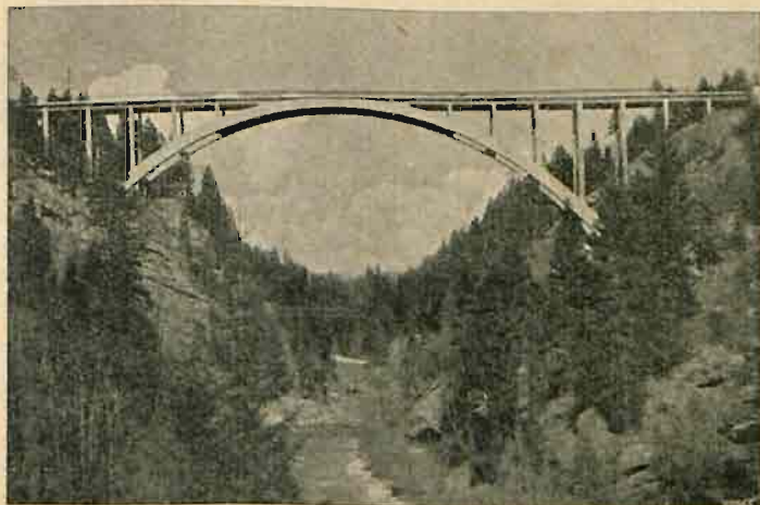
Rys. 12. Most pod Echelsbach: łuk żelbetowy rozpiętości 130 m.
