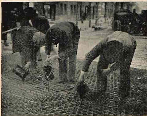
Rys. 31. Droga stalowa systemu „Schmid”: zalewanie siatki masą bitumiczną i asfaltem lanym.
