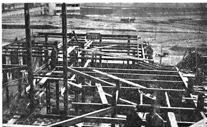
Fig. 2. Ukośne podciąg stropowe.
