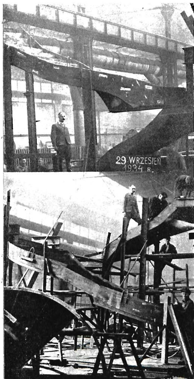
Fig. 16 i 17. Schody podczas wykonywania w warsztatach Zakładów Ostrowieckich.
