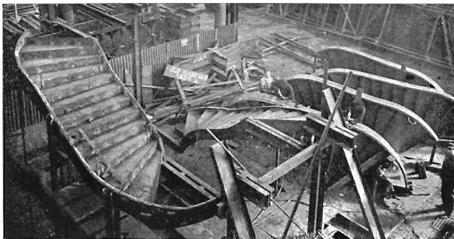
Fig. 18. Schody podczas wykonywania w warsztatach Zakładów Ostrowieckich.
