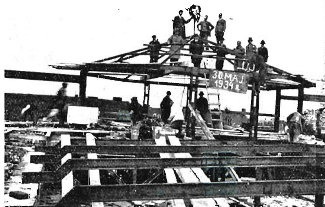
Fig. 12. Krokwie dachowe i świetlik.
