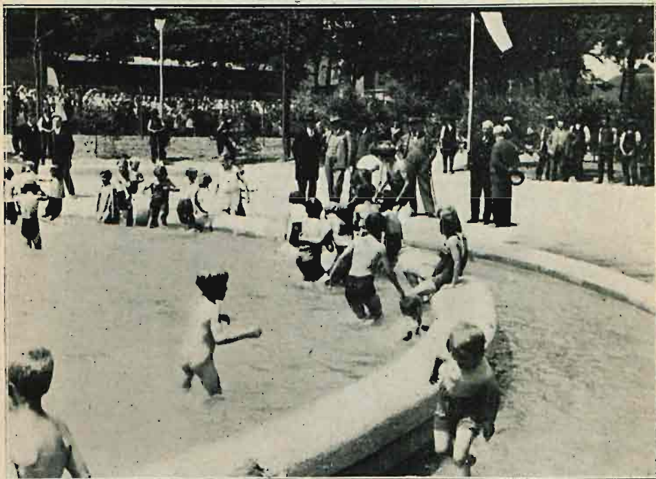
Wokoło basenu urządzono 1½ mtr. szeroką rynną betonową 10 cm. głęboką, tak, że dzieci muszą do basenu przejść przez wodę w tej rynnie i tym sposobem splukać sobie piasek z nóżek nie zanieczyszczając właściwego basenu
