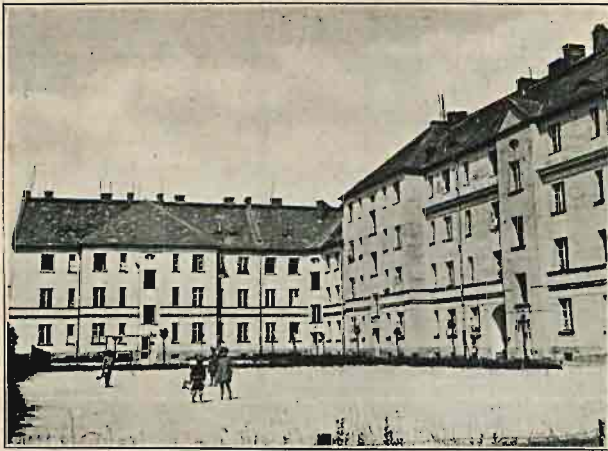
Podwórze domu zbudowanego dla urzędników miejskich przez Miasto. Wszystkie mieszkania mają wiele światła i wszystkie dadzą się dwustronnie przewietrzać.
