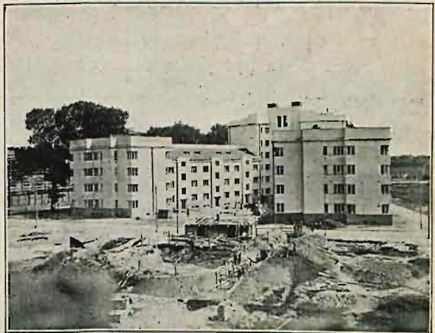
Budowla spółdzielcza na b. niekorzystnej parceli. Właściciele budowli zrezygnowali z zabudowania całego frontu od ulicy, by nie pozbawiać mieszkańców dostatecznego naświetlenia całości wszystkich mieszkań.
