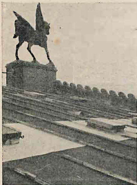
Dach Opery w Frankfurcie n/M., kryty blachą cynkową 50 lat temu.
