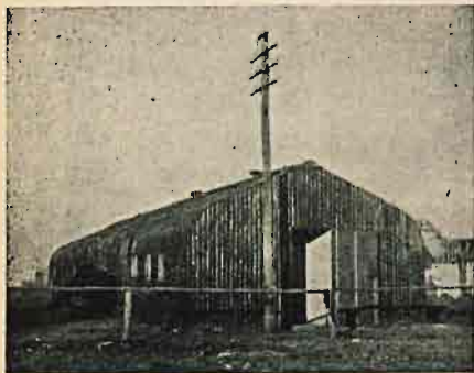
Baraki dla robotników w Gdyni.
