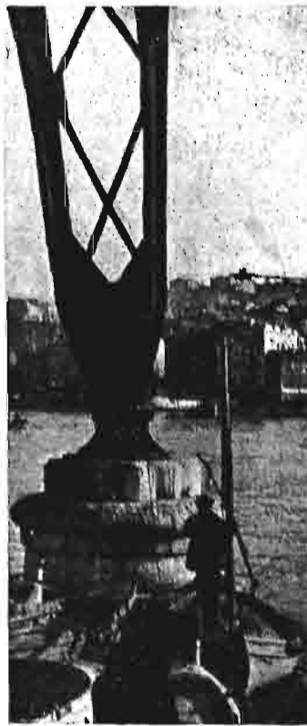
Ryc. 41. Most przewozowy w Marsylii, stopa pylona.
