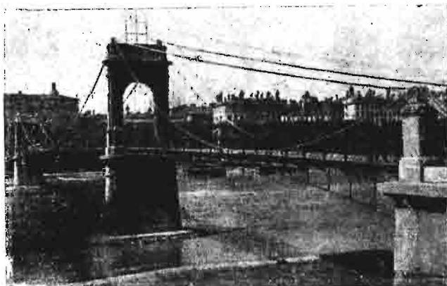
Ryc. 34. Kładka du Collège na Rodanie w Lyonie.
