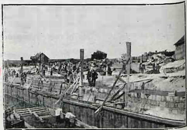
Fot. Jackowski. 3. Port w Nadbrzeziu. Budowa wysokiego bulwaru.
