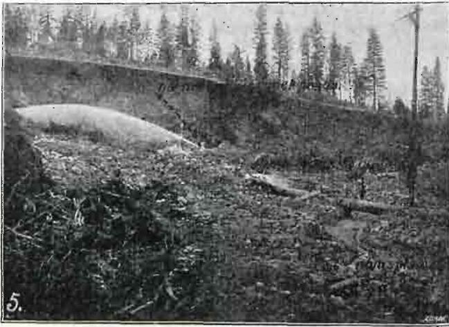
Rys. 5. Przedstawia mechaniczne wzruszanie materiału przy pomocy siły wody.
