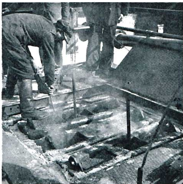
PIEC KOMOROWY DO PÓLKOKSOWANIA. USTAWIANIE RETORT.
