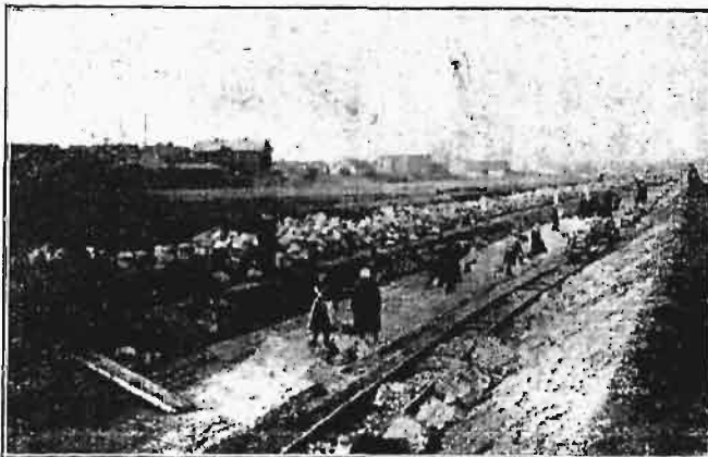
Rys. 10. Budowa koryta Rawki.
