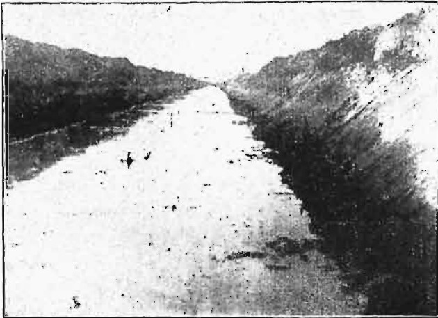
Rys. 12. Wykop kanału osuszającego na Polesiu.
