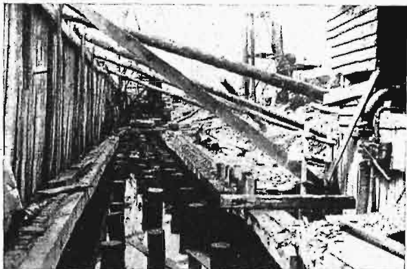
Rys. 4. Budowa bulwaru w porcie Warszawskim.
