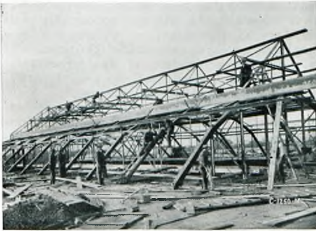
Rys. 7. Wiązary dachowe w czasie montażu.
