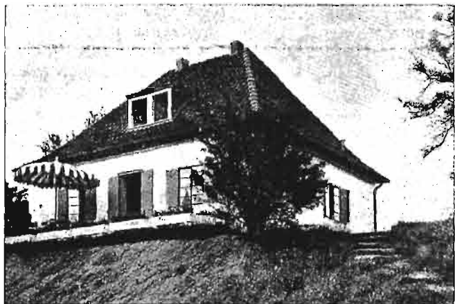
Rys. 3. Dom stalowy syst. Blecken.
