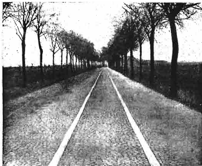
Droga z drobnej kostki ze Stade do Jorku z torem żelaznym dla furmanek.
