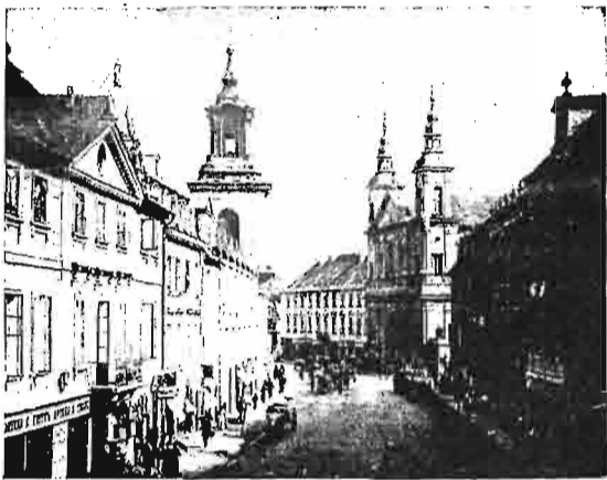
Rys. 1. Ul. Freta przy wylocie Długiej 1) .
