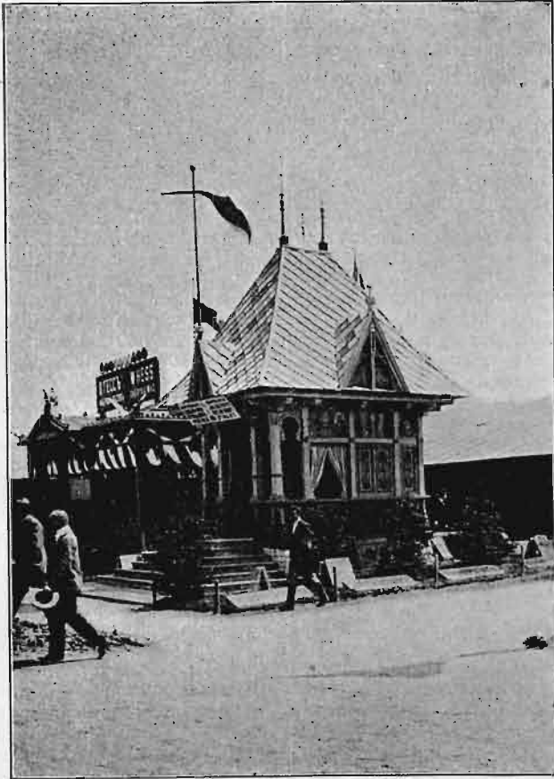
Pawilon fabryki wag „W. Hess“ i fabryki cementu portlandzkiego „Firley“.
