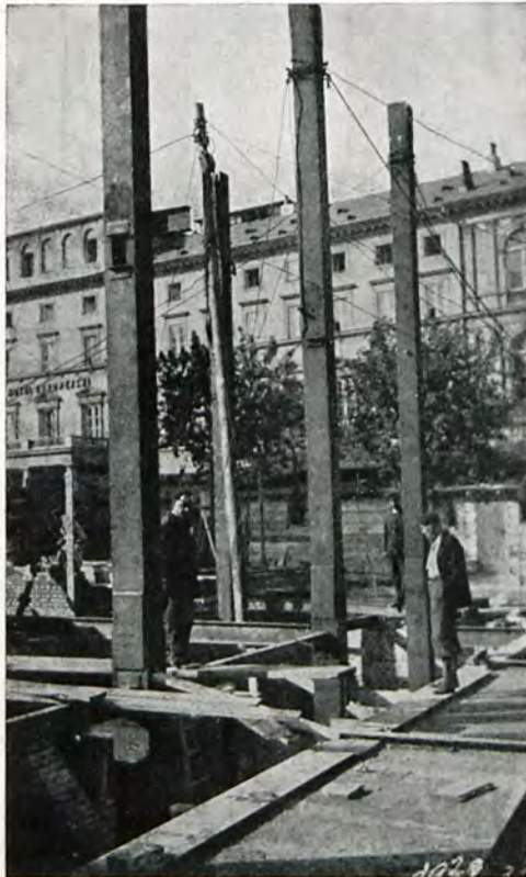
Rys. 10. Otwór w słupie dla podciągu ciągłego.
