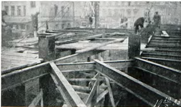
Rys. 3a. Układ belek w narożniku.
