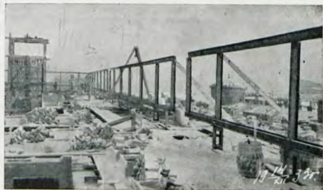
Rys. 20. Podciąg dachowy.
