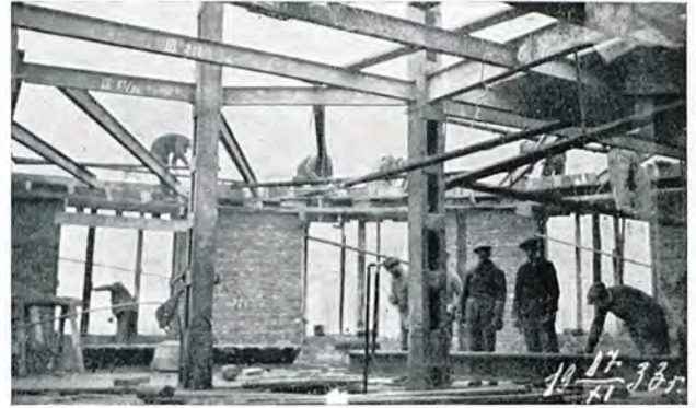
Rys. 3b. Układ belek w narożniku.
