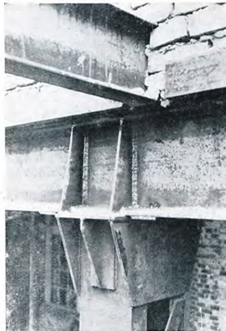
Rys. 16. Połączenie słupa z podciągiem
