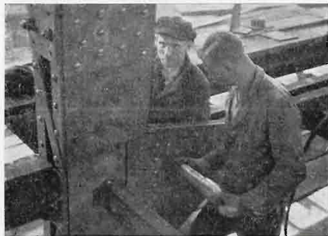
Fig. 2. Nitowanie pneumatyczne szkieletu.
