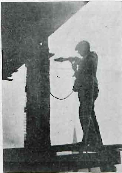
Fig. 5. Torkretowanie szkieletu.
