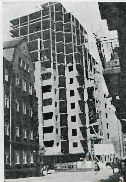
Fig. 6. Szkielet gmachu podczas obudowy.
