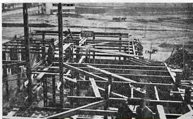
Fig. 2. Ukośne podciąg stropowe.
