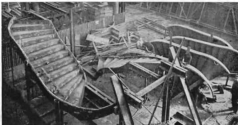
Fig. 18. Schody podczas wykonywania w warsztatach Zakładów Ostrowieckich.
