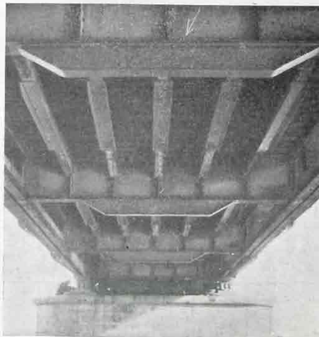
Fig. 10. Wzmocnienie poprzecznic i podłużnic.
