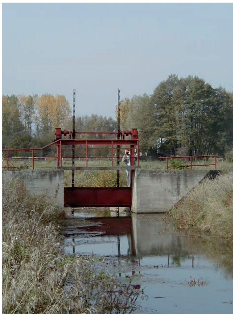
Rys. 2.6. Rów melioracyjny z zastawką w okolicach Opatctwa (fot. M. Adamczyk)
