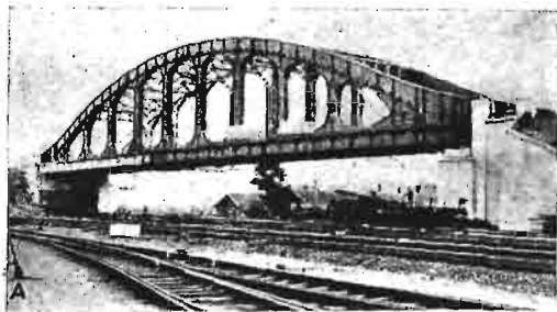
Rys. 3. Most dwutorowy syst. Vierendeel'a .
