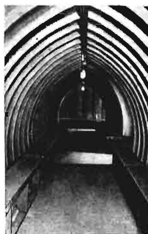
Rys. 2. Wnętrze schronu z elementów stalowych.
