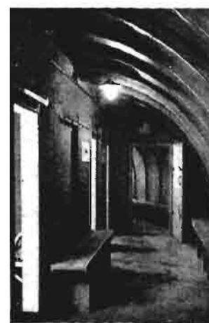
Rys. 3. Wnętrze szerokiego schronu stalowego ze ściankami podziałowymi
