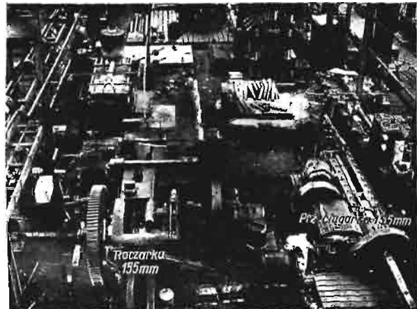
Rys. 9. Prasy tłoczące i przeciągające do skorup 155 mm (Eumuco).
