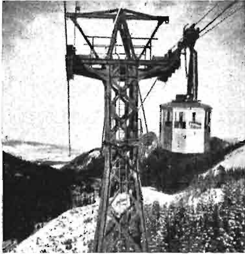
Rys. 5. Przejście wagonu przez podporę.
