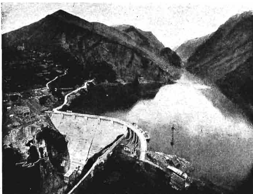
Rys. 1. Widok ogólny zapory i zbiornika.
