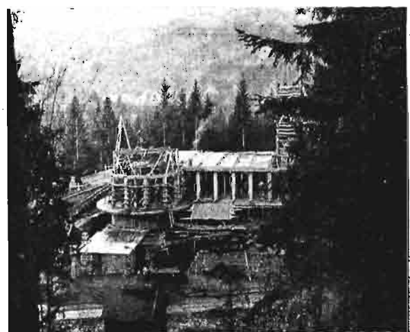
Rys. 3. Wiązary rurowe po zmontowaniu.
