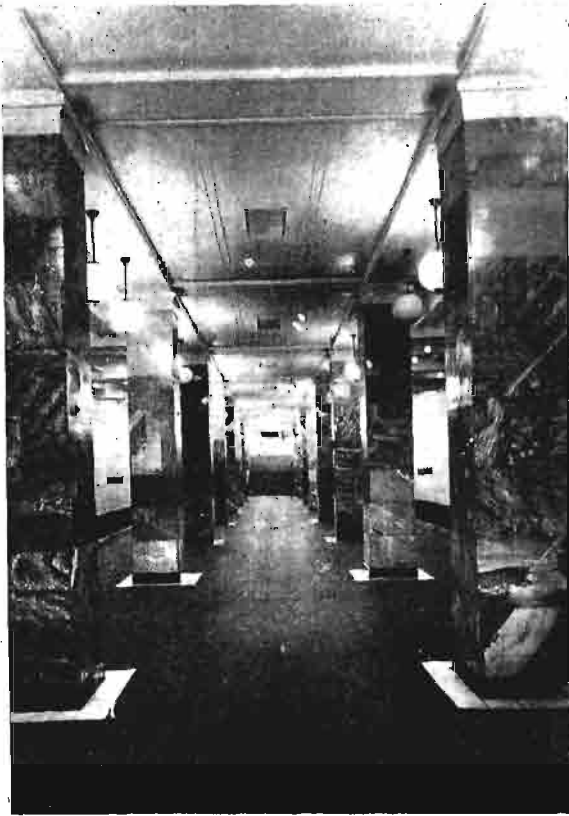
Rys. 4. Przedśionek stacji Sokolniki.
