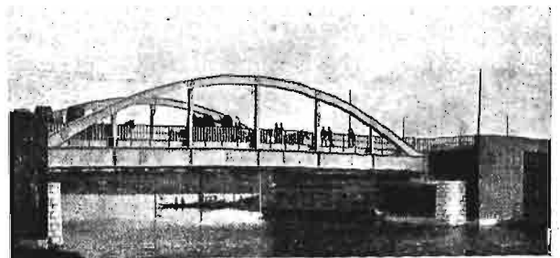
Rys. 1. Most na kanale Wassel w Rethen; rozpiętość 52 m.
