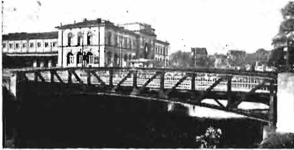
Rys. 2. Most przed dworcem w Brunświku, rozp. 21,8 m.
