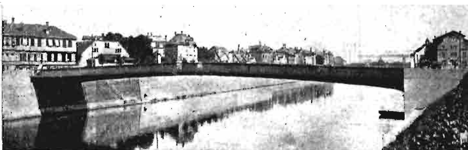
Rys. 4. Most Wilhelma nad rz. Neckar w Cannstadt, rozp. 70 m.
