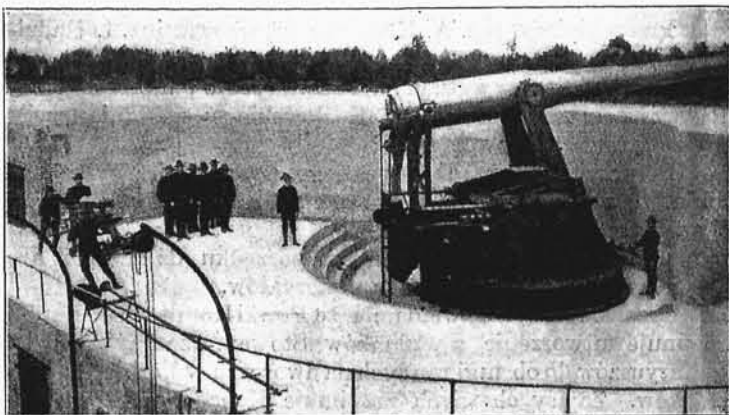
Rys. 1. Strzelanie z dział 12-calowego, chowającego się za parapet betonowy.
