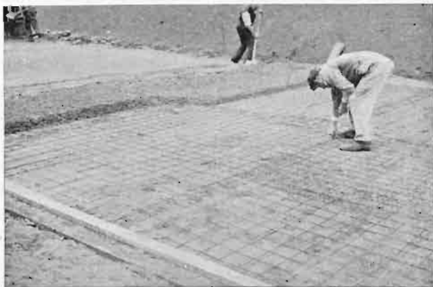
Rys. 172. Układanie siatki stalowej przy budowie jezdni betonowej.
