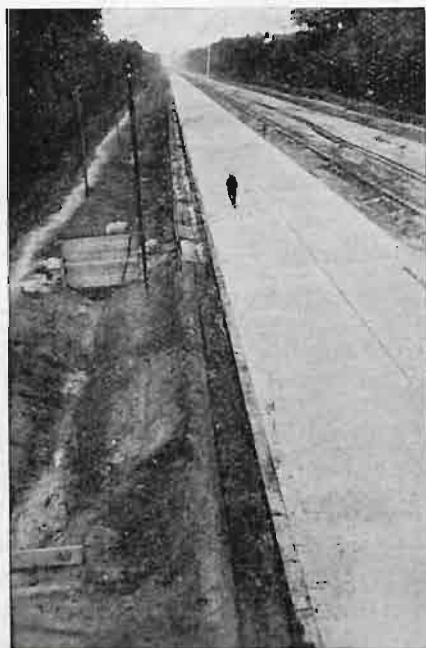
Rys. 173. Jezdnia betonowa wykończona na połowie szerokości.
