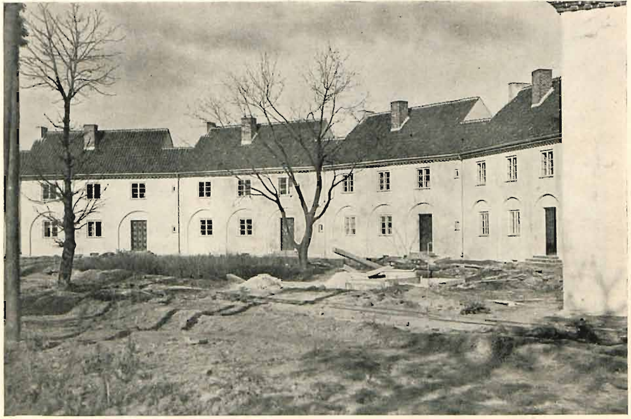
ARCH. R. GUTT. DOMY PRZY PLACU «OKRĄGLAK».
