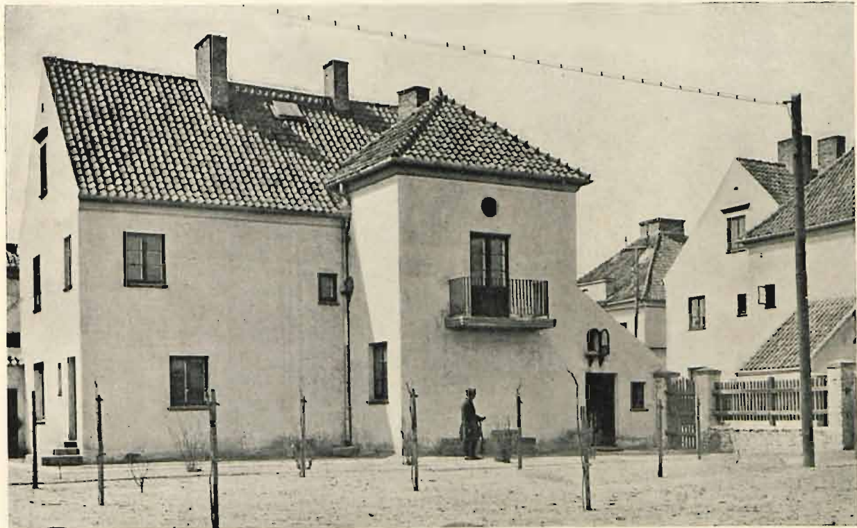
ARCH. R. GUTT. DOM KAPITANA P. OD STRONY OGRODU.
