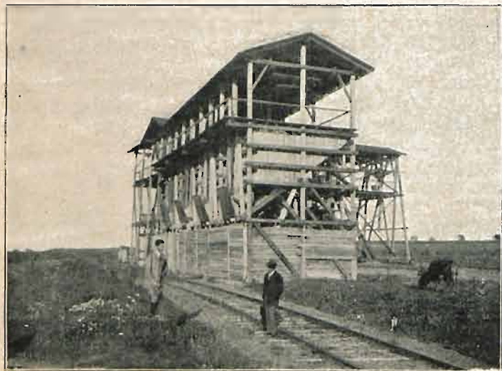
Rys. 18. Ładownia kamieniołomu w Kozach.
