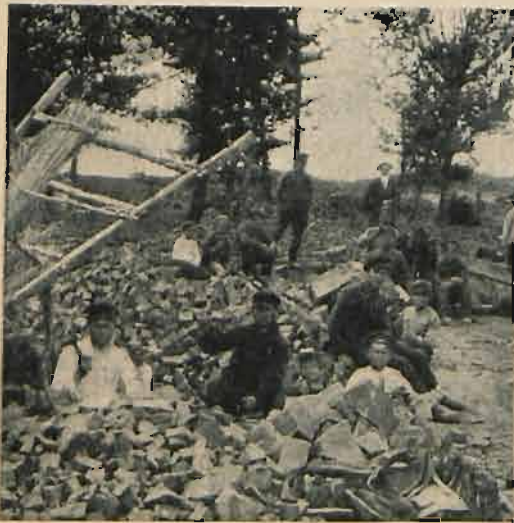
Rys. 5. Ręczny wyrób drobnej kostki w Berestowcu.
