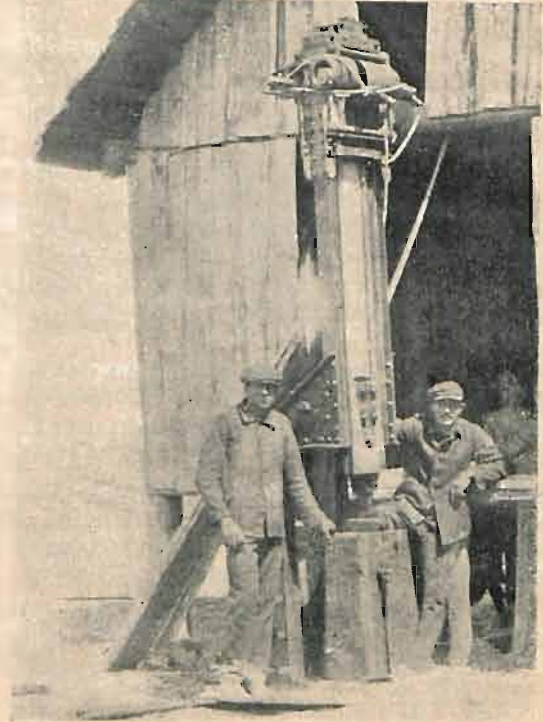
Rys. 6. Maszyny do wyrobu drobnej kostki w Berestowcu.
