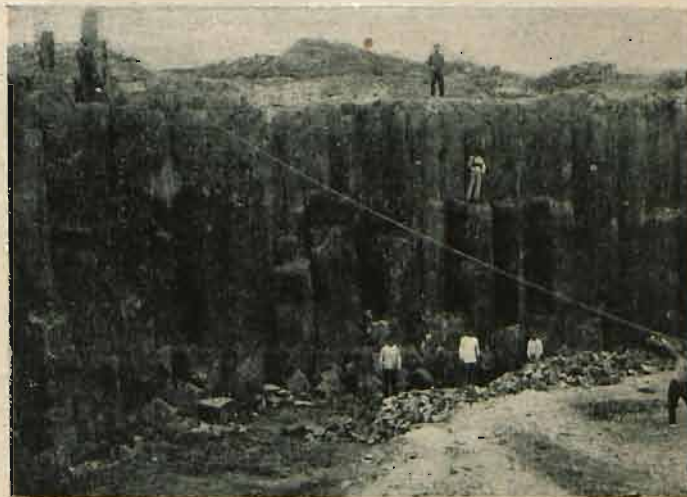
Rys. 3. Pokłady bazaltowe w Berestowcu. Wylamywanie kamienia.
