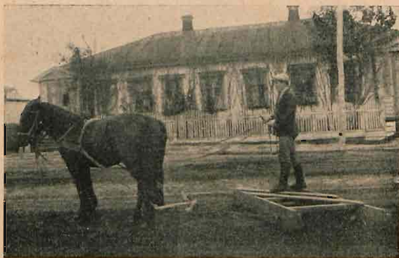
Fig. 57. Włok drewniany używany na robotach drogowych armji rosyjskiej podczas wojny.
