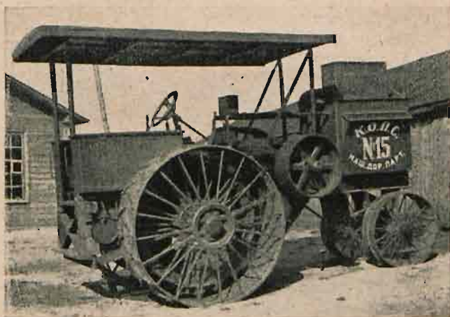
Fig. 69. Traktor „Case“ o sile 30 HP.
