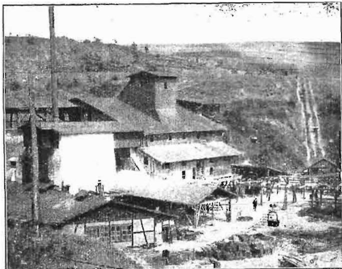
Rys. 14. Widok ogólny budynków maszynowych kamieniołomu w Miękinii.
