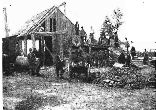
Rys. 4. Tłukarka w Berestowcu do produkcji tłucznia.
