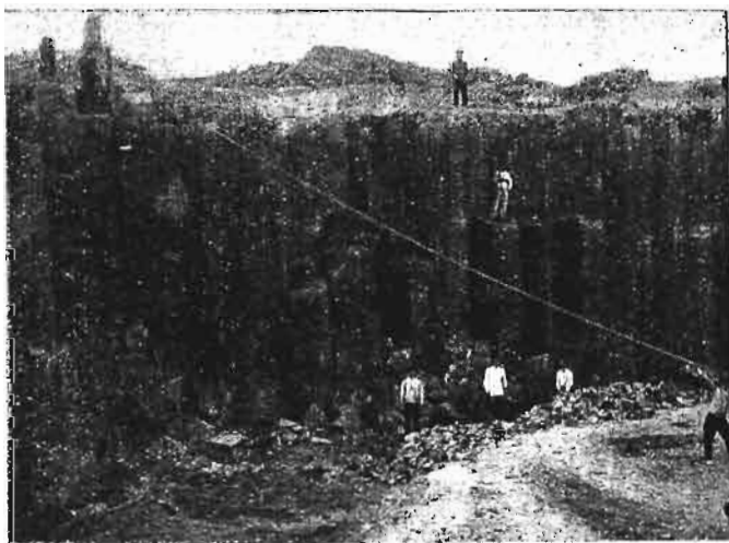
Rys. 3. Pokłady bazaltowe w Berestowcu. Wyłamywanie kamienia.
