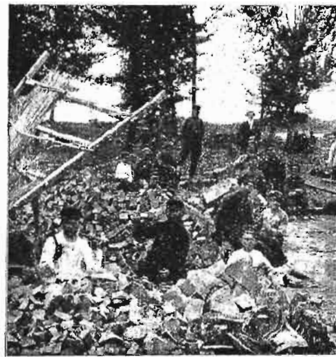
Rys. 5. Ręczny wyrób drobnej kostki w Berestowcu.
