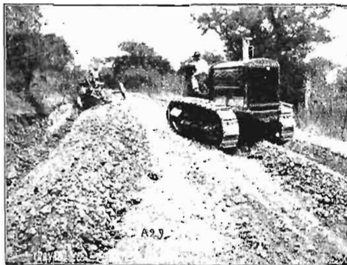
Rys. 12. Ciągówki (traktory) „Holt“ służą za siłę pociągową dla struga drogowego „Mogul“.
