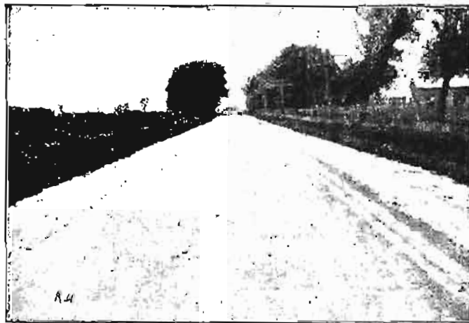
Rys. 14. Wygląd drogi gruntowej, ulepszonej zapomocą maszyn drogowych.
