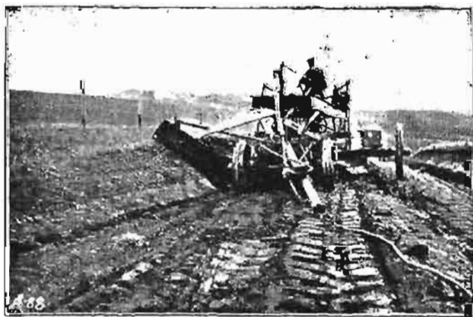
Rys. 11. Powierzchnie wykopów są ściane, zapomocą przyrządu do kopania rowów.
