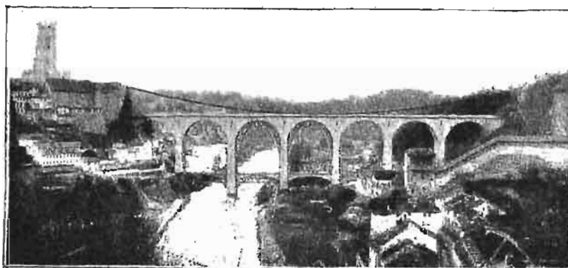
Rys. 3. Widok mostu Zähringen.
