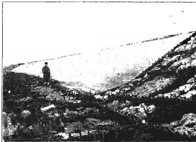
Rys. 2. Ostona brzegowa syst. Decauville'a wykonana w r. 1913 na brzegu Dniepru. U dołu i na pierwszym planie — materace faszynowe.
