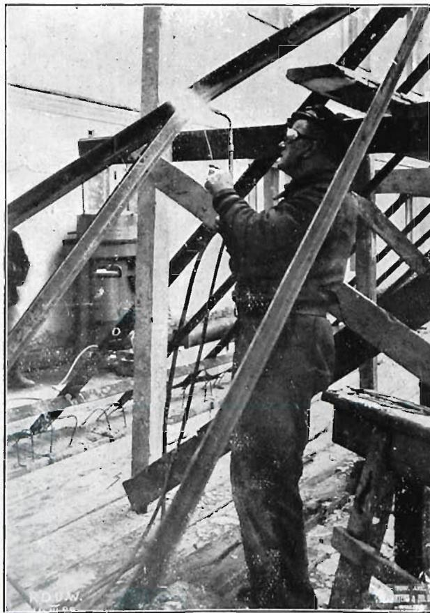
Fig. 10. — ASSEMBLAGE DE DEUX SECTIONS DE LA VERRIÈRE RECTANGULAIRE.
