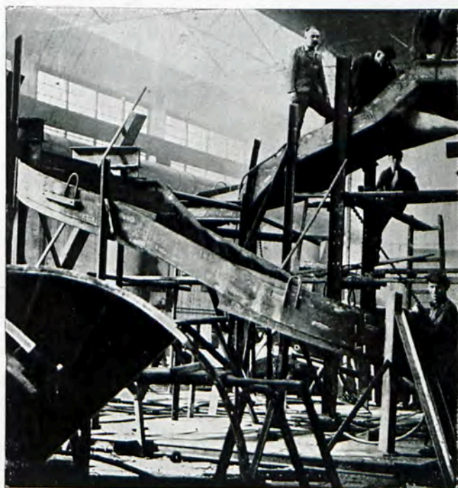
Fig. 563. Montage de l'escalier à l'atelier. Vue montrant l'exécution délicate de cet escalier.
