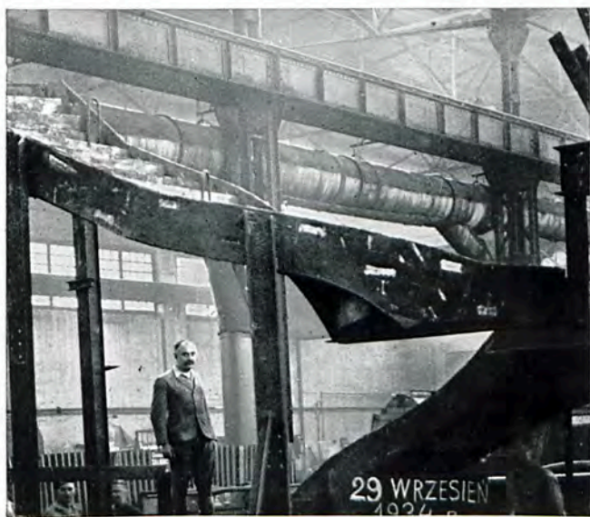
Fig. 562. Montage de l'escalier à l'atelier. On aperçoit bien le limon extérieur.
