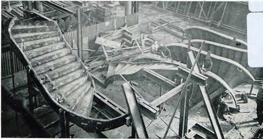
Fig. 564. Escalier pendant son montage à l'atelier.
