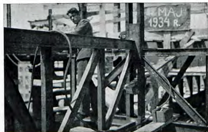
Fig. 558. Vue des poutres en treillis léger.
