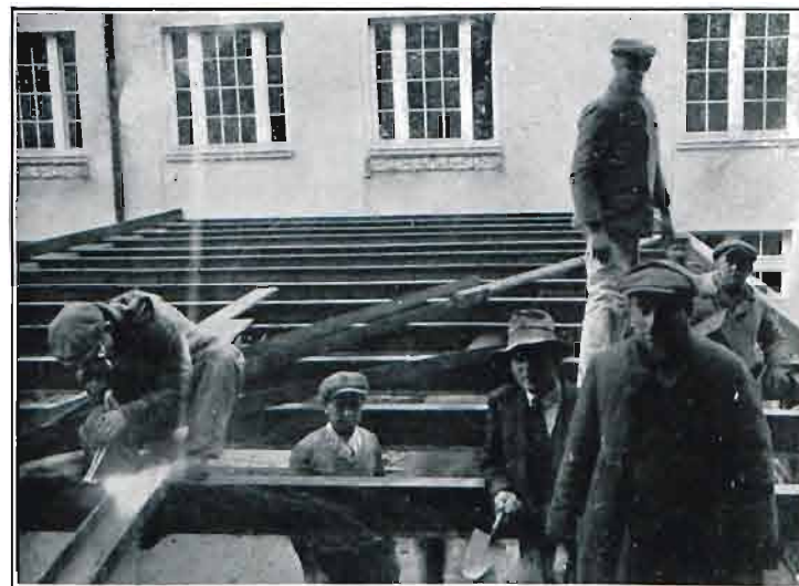
Fig. 62. — Confection du toit plan de la partie C.
