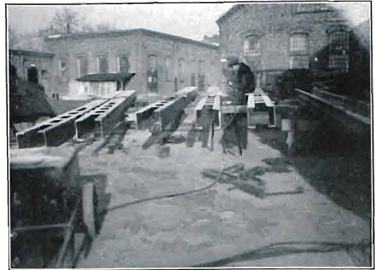
Fig. 15. — Soudure de la colonne.
