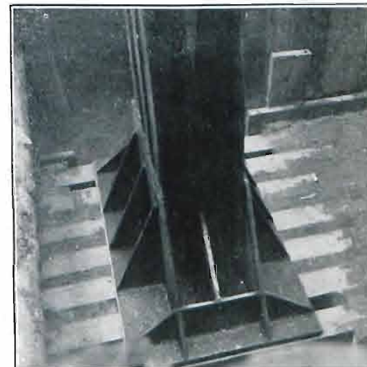
Fig. 11. — Colonne sur les poutres des fondations soudées bout-à-bout.
