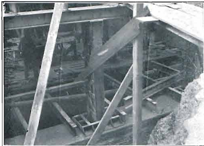
Fig. 33. — Pilier en sous-sol du bâtiment B. Słup w piwnicy budynku B.
