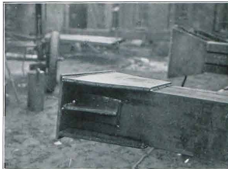
Fig. 19.— Base de la colonne achevée.
