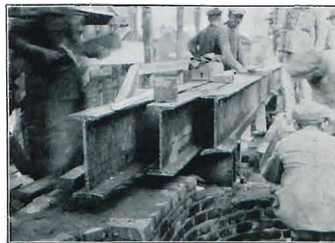
Fig. 45. — Découpage d'une poutre pour aménager la grande entrée.
