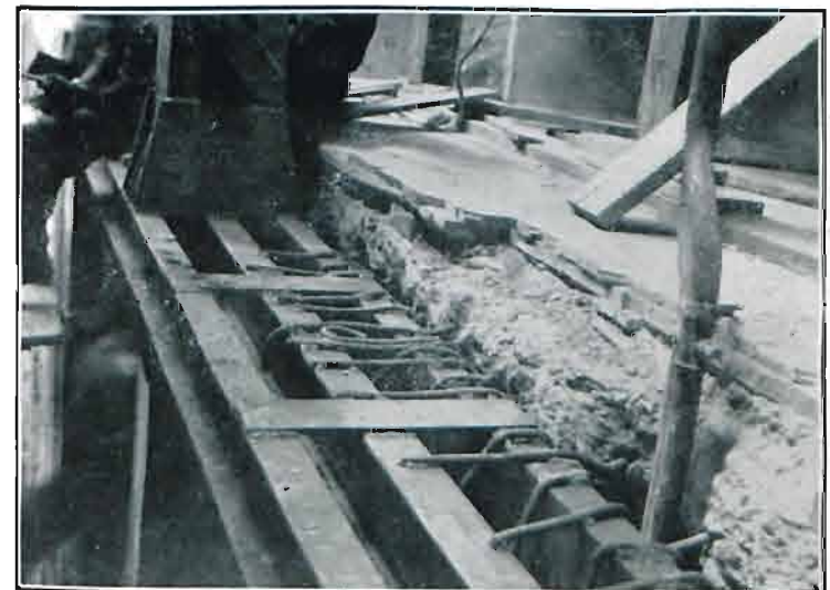
Fig. 66. — Jonction de l'ancien bâtiment en béton armé avec la construction soudée.
