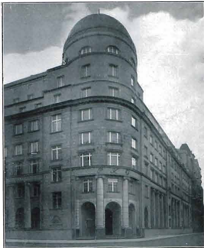
Fig. 1 — Vue de la façade. Widok fasady.
