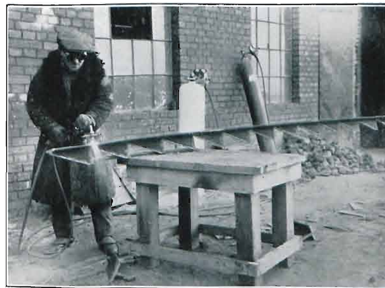
Fig. 20.— Découpage des consoles au chalumeau.
