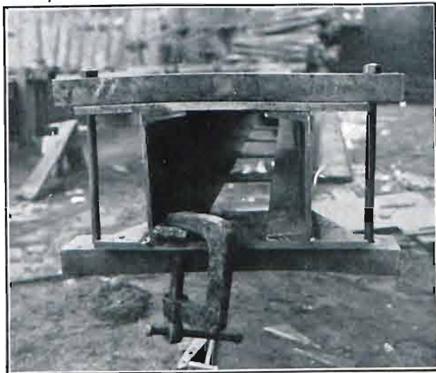
Fig. 14. — Base de la colonne préparée pour la soudure.
