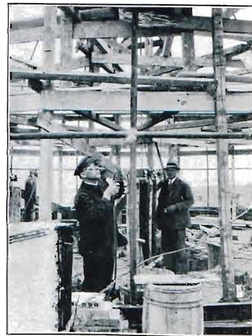
Fig. 128 Soudure d'un nœud. Spawanie węzła.
